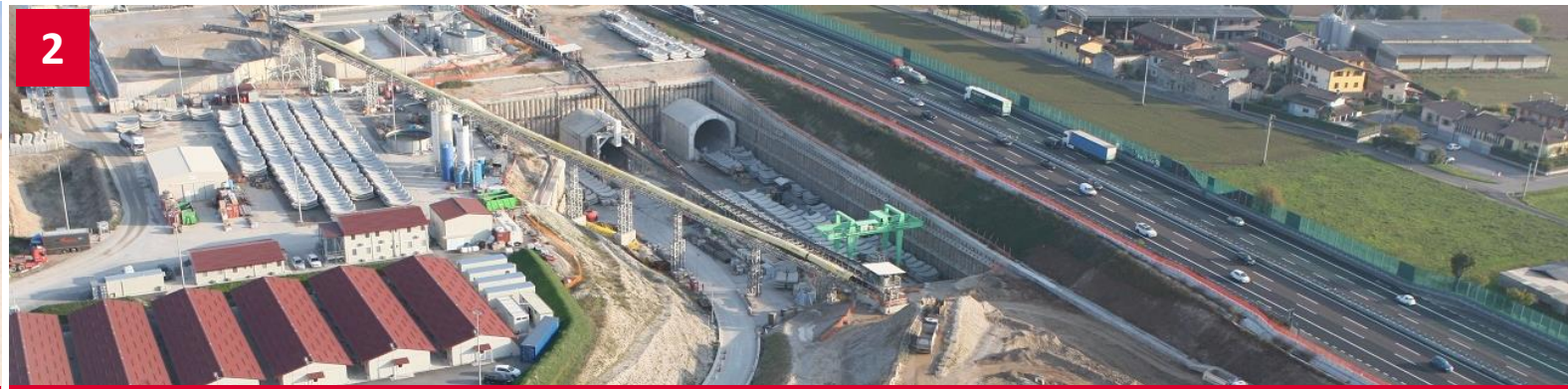
Imbocco Galleria Naturale di Lonato Ovest
