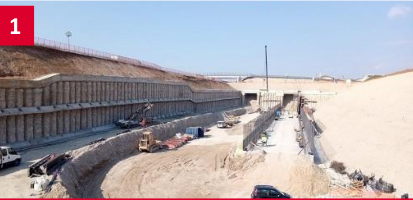
Galleria Artificiale di Lonato Ovest
